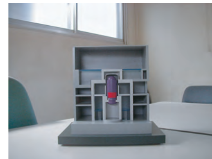
圧力容器の組込、上部蓋・天井を組立
