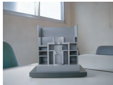
格納容器、鋼板、生体遮蔽壁を組立
